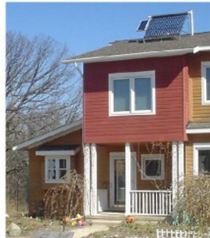
Fig.30.2: Ein solares Warmwassermodul, das heißes Wasser für eine Familie in Michigan bereitstellt. Die Pumpe des Systems wird von dem kleinen PV-Modul links angetrieben.
