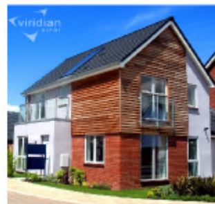
Fig.6.3: Solarenergie erzeugt durch ein 3-m 2 -Warmwassermodul (grün) und zusätzliche Wärmeanforderung (blau) für die Warmwassererzeugung im Testhaus von Viridian Solar. (Das Foto zeigt ein Haus mit so einem Modul auf dem Dach.) Die mittlere Solarleistung von den 3 m 2 war 3,8 kWh/d. Das Experiment simulierte den Warmwasserbedarf eines durchschnittlichen europäischen Haushalts – 100 l heißes (60°C) Wasser täglich. Die 1,5-2 kWh/d große Lücke zwischen der gesamten erzeugten Energie (schwarze Linie ganz oben) und dem genutzten Warmwasser (rote Linie) ist durch Wärmeverluste entstanden. Die Linie in Magenta zeigt die für den Betrieb erforderliche elektrische Leistung. Die mittlere Leistung pro Flächeneinheit beträgt bei diesem Modul 53 W/m 2 .
