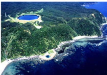
Fig.26.11: (unten) Okinawa Pumpspeicherkraftwerk, dessen Unterwasser der Ozean ist. Gespeicherte Energie: 0,2 GWh. Foto mit freundlicher Genehmigung von J-Power [www.ieahydro.org](http://www.ieahydro.org)
