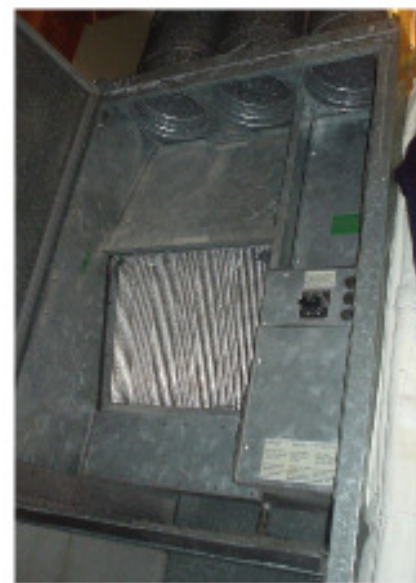
Fig.E.11: Der Wärmetauscher im „Heatkeeper“
