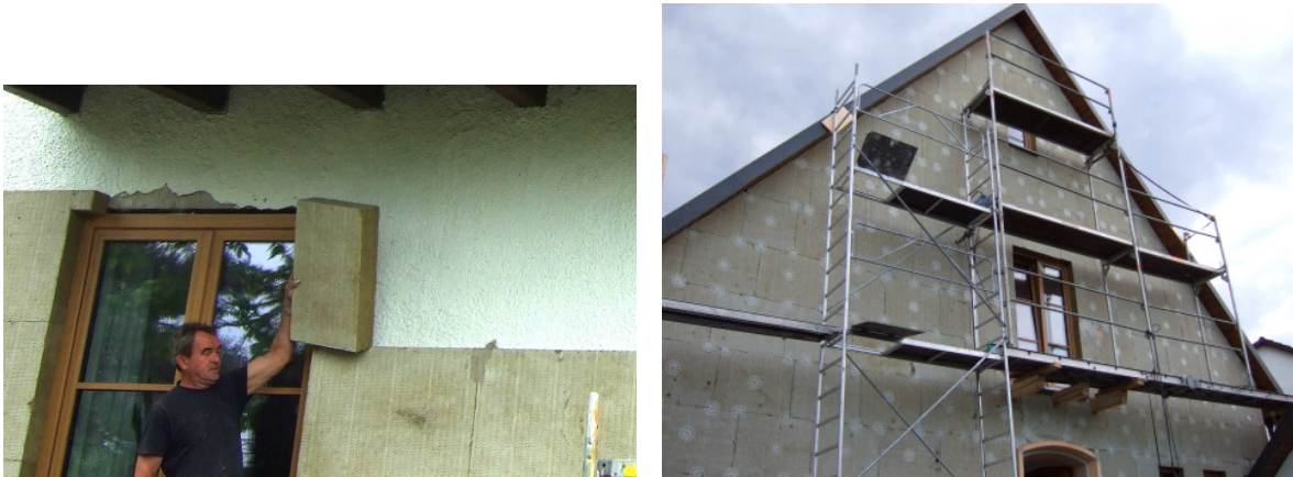
Fig. E.9b: Außen-Wanddämmung an einem Altbau. (links) Die Fassadendämmung wird aufgebracht. (rechts) Die verdübelten Dämmplatten können verputzt werden. Fotos: Pia Huber
