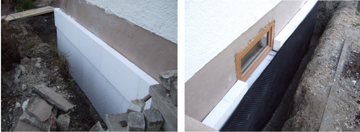
Fig. E.9a: Außen-Wanddämmung an einem Altbau. (links) Dämmung im Kellerbereich: Das Fundament wird 1-2 m unter Umgebungsniveau freigelegt und mit Dämmplatten beklebt. (rechts) Eine Abdeckfolie schützt die Kellerdämmung vor Beschädigungen und Feuchtigkeit aus dem Erdreich. Fotos: Pia Huber
